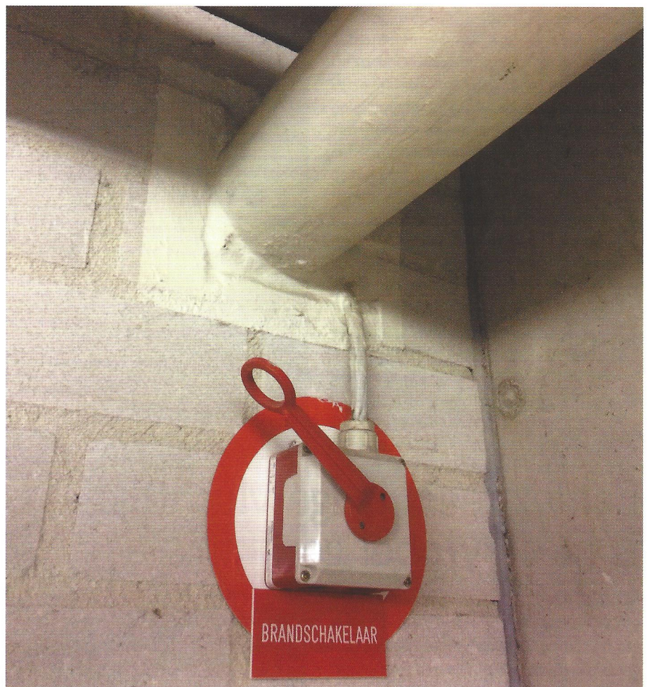
Een veel voorkomende fout: flinke metalen buis die alleen licht is ingesmeerd met opschuimende verf.
